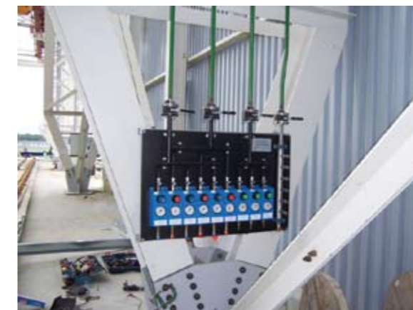
Stație fixă de distribuția gazelor-diferite gaze
